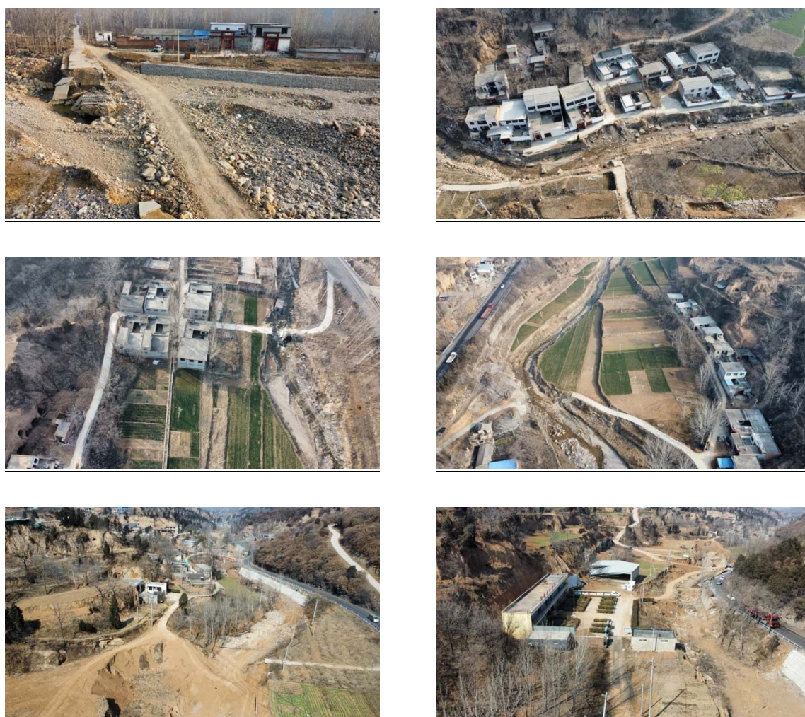
图 4-4 部分水毁公路现状
