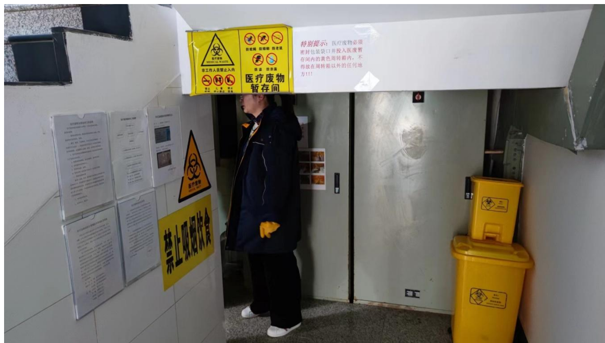
图 3.9-5 现有医疗废物暂存点
