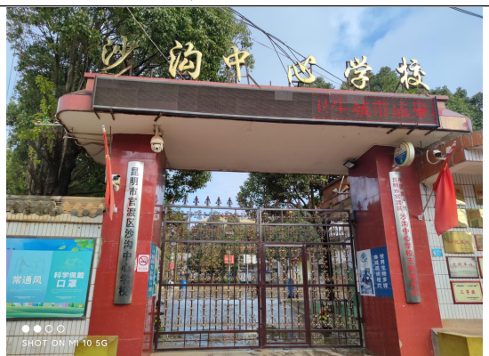
沙沟中心学校（已采取隔声措施）
