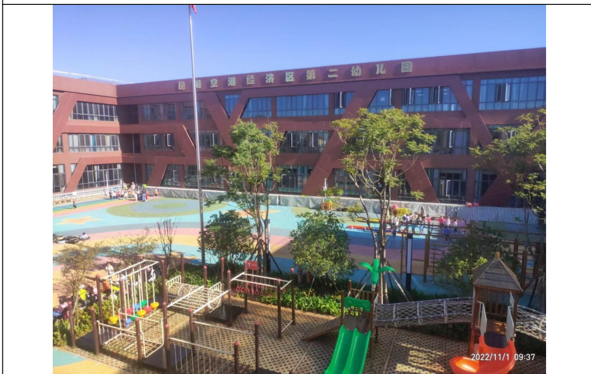
昆明空港经济区第二幼儿园已安装隔声窗
