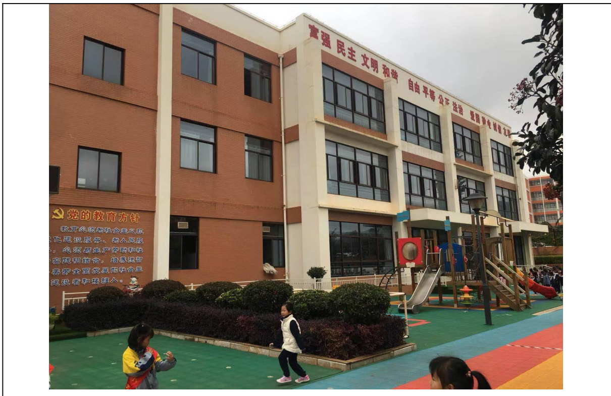
昆明空港经济区第一幼儿园已安装隔声窗
