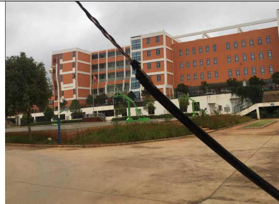
昆明空港第一小学（已安装隔声措施）
