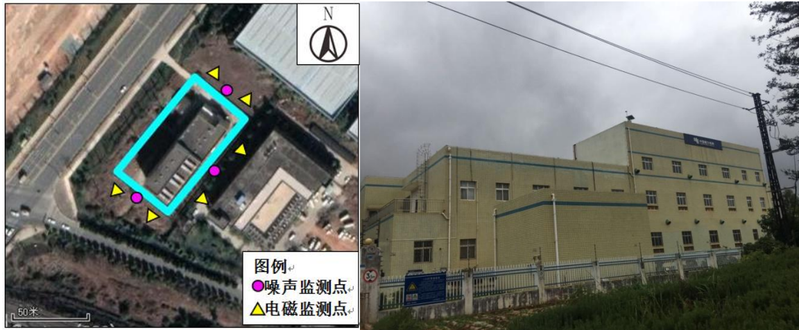
图 5.4-1 110kV 螺蛳湾变电站现状监测点
