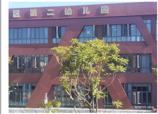
昆明空港经济区第二幼儿园（已安装隔声措施）
