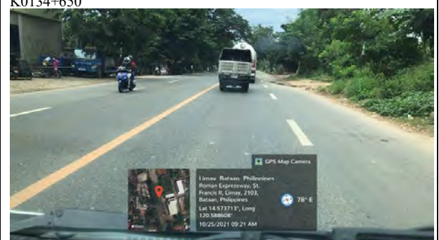
K0142+675 (Lamao Bridge)
