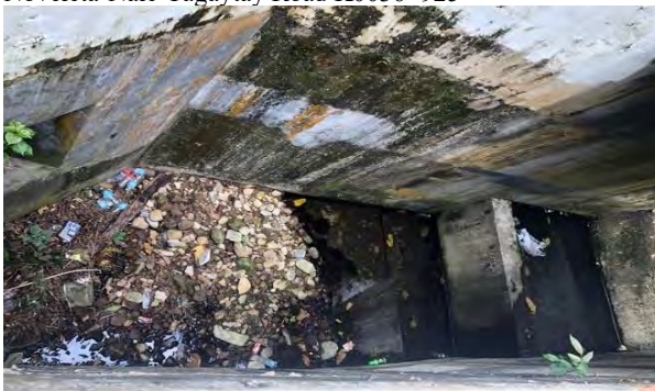
Nasugbu Road K0070+000 (Kaybiang Tunnel)
