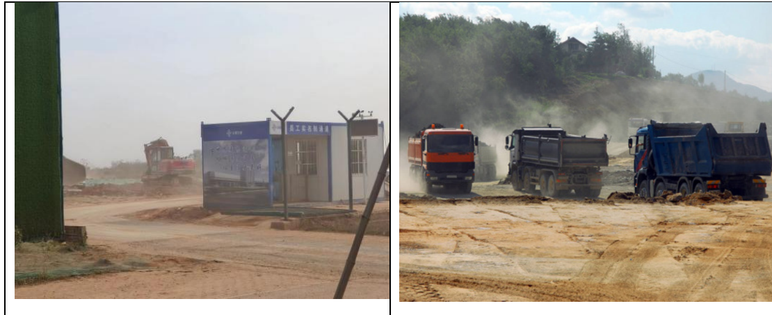
图 8.5-7 项目施工现场
