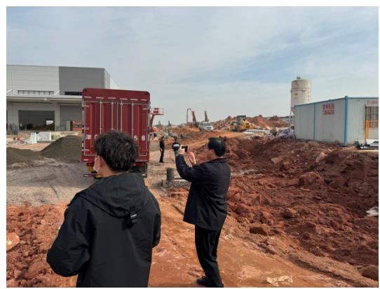
先期启动项目施工现场
