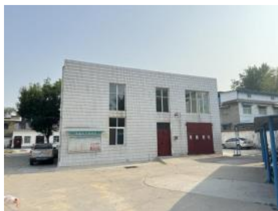
向阳雨水泵站选址
