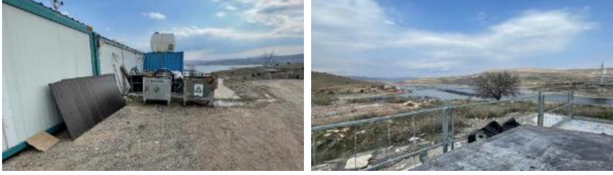
Şekil 90. Ağın Şantiyesi ve Çevresi
